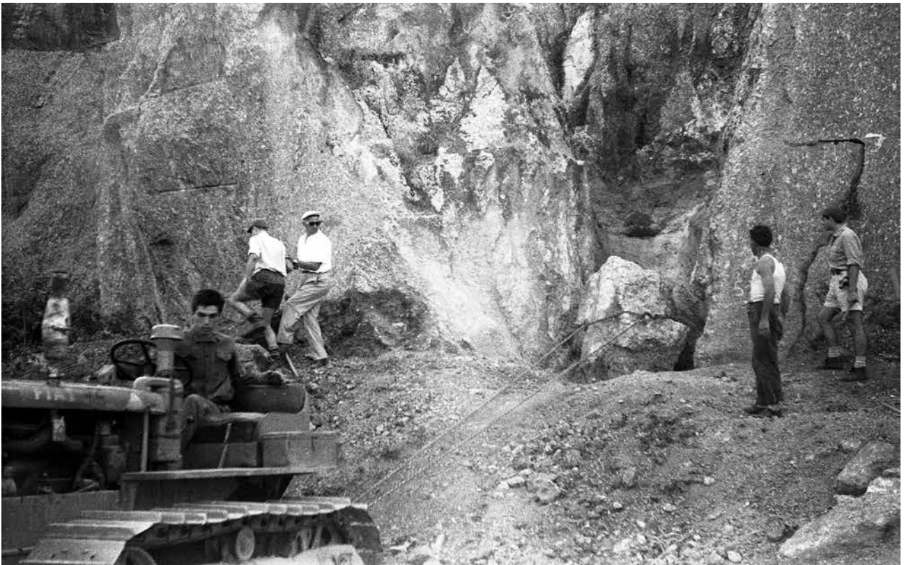
Fig. 4 – Ex Cava a Filo 1964. Si asportano i blocchi di roccia che ostacolano la prosecuzione degli scavi (Archivio Storico GSB-USB).
